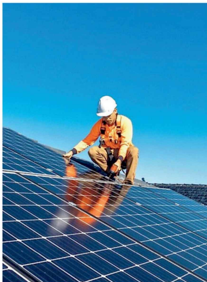
Un tecnico al lavoro per installare un pannello fotovoltaico
