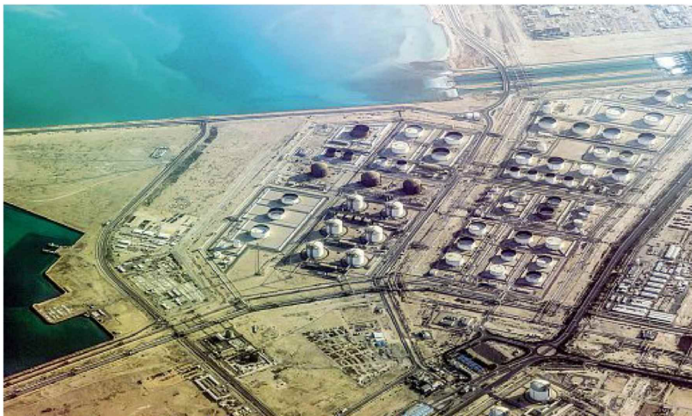
Gli impianti per la liquefazione del gas naturale di Ras Laffan, nel Qatar. Il sito è stato gravemente danneggiato dai missili lanciati dall'Iran
