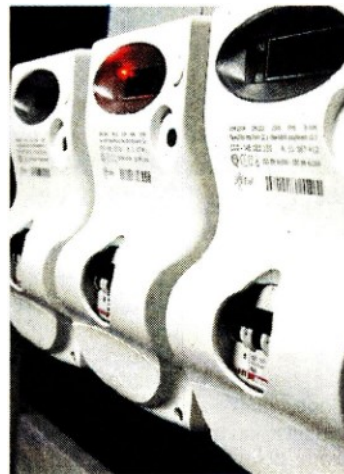
Contatori della corrente elettrica
