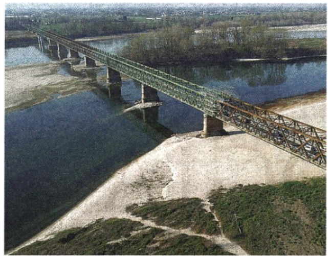
Livelli estivi Il Po in secca sotto il ponte della Becca a Linarolo (Milano)
