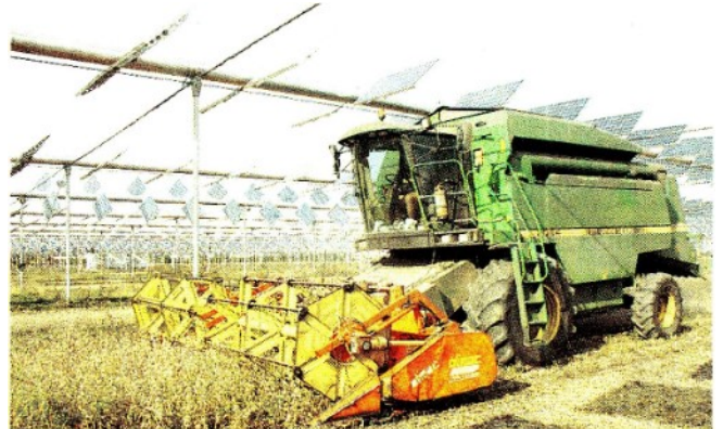
Sperimentale. Il sistema Remtec, con moduli fotovoltaici a inseguimento biassiale
