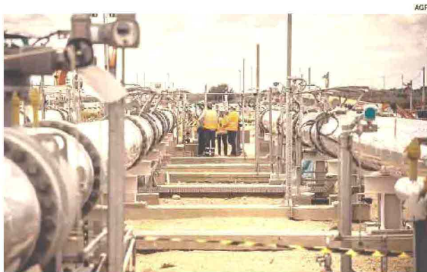
Puglia. Nella foto il cantiere della TAP a Melendugno (LE), il paese approdo del Gasdotto Trans Adriatic Pipeline.
