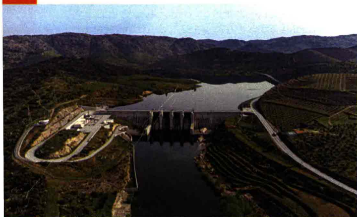
Una diga appena realizzata in Portogallo per sfruttare l'idroelettrico come energia rinnovabile e pulita.
